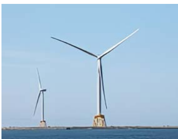
風力発電（下部がジャケット基礎）引用：石狩市HPより
