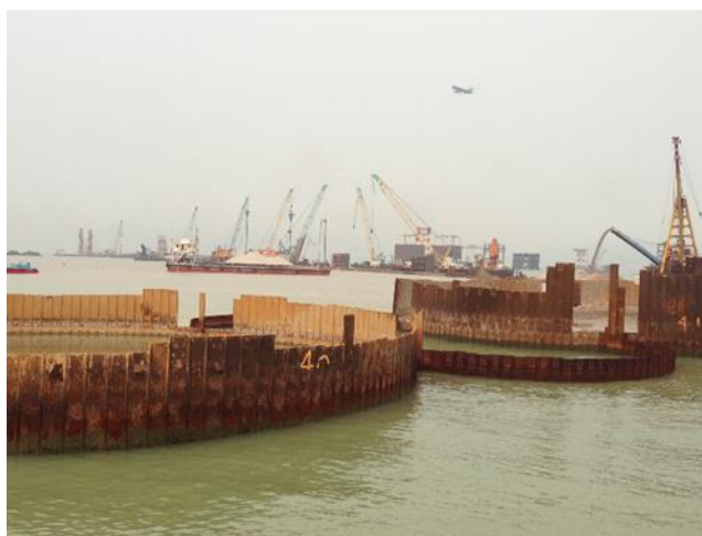
人工島の工事風景。茶色の板状の物が鋼矢板
