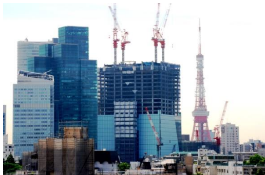
建設現場に欠かせない鉄骨や骨組み
