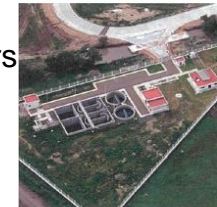
排水処理設備 (Santa Fe)
