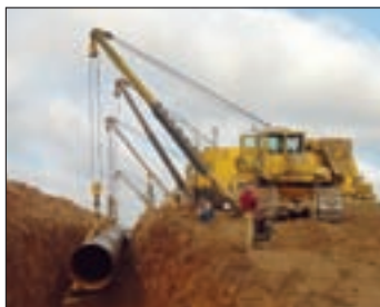
「ガスパイプライン敷設現場で活躍する当社出荷のパイプレイヤー」
