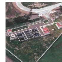
排水処理設備 (Santa Fe)
