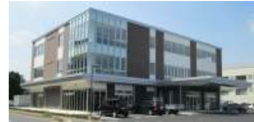
3階建事務所施工例
