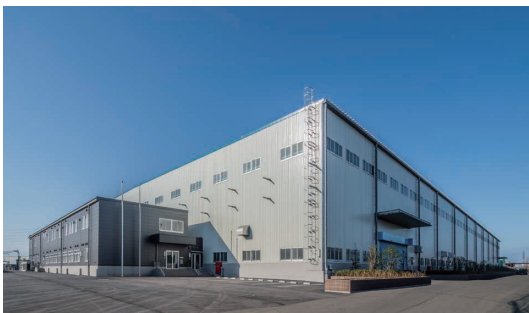
新しい建屋の外観
