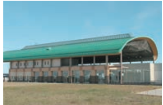
つくばエクスプレス・みらい平駅に使用されたフッ素GL鋼板
