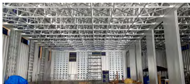
NSスーパーフレーム工法®(施工時)
