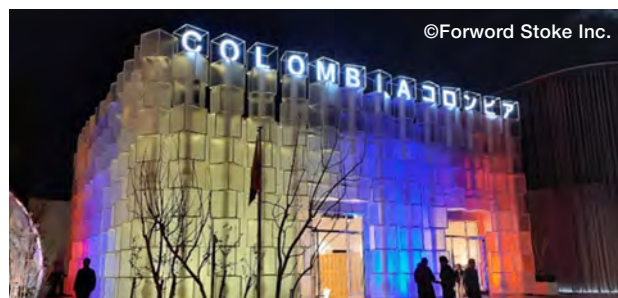
コロンビア館建屋完成
