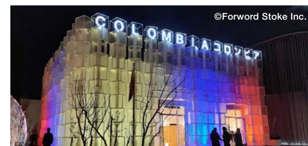
コロンビア館建屋完成
