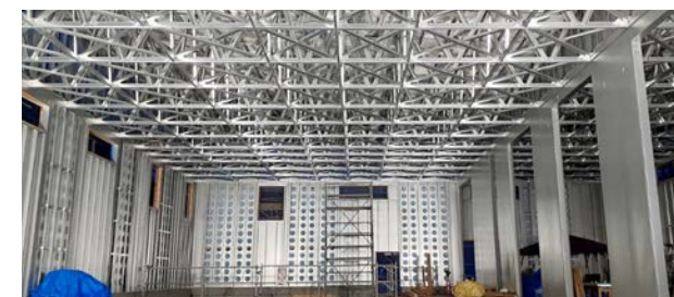
NSスーパーフレーム工法®（施工時）
