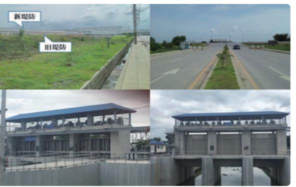
■国際協力機構(JICA)より、「新堤防建設時には、2011年洪水発生時の最高到達水位+6.05mの余裕高を持つべき」とのアドバイスも参考にし、海拔+6.05mの防水堤を周囲約73kmにわたり建設済
